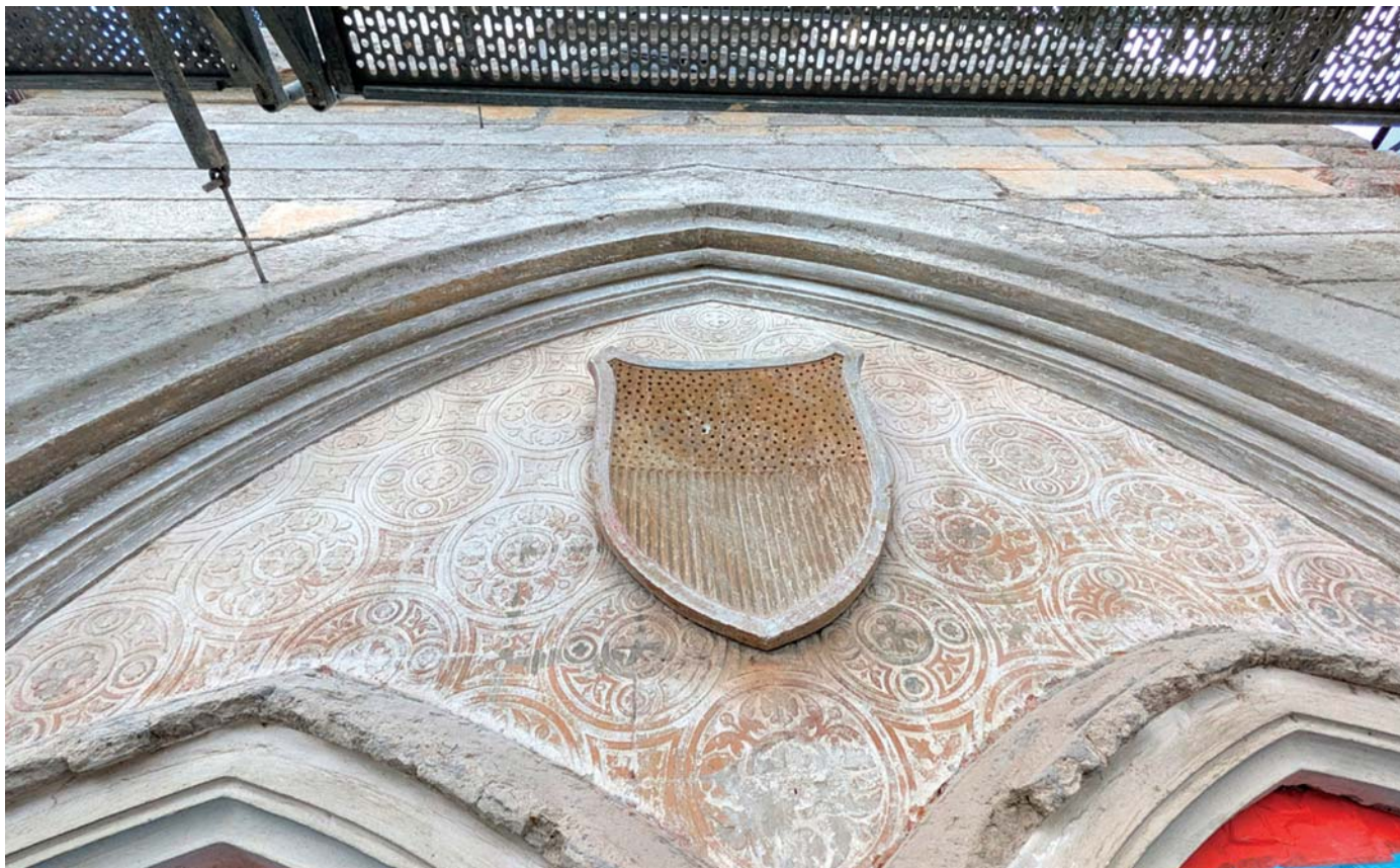
1: Detail vstupu na balkon radniční věže
