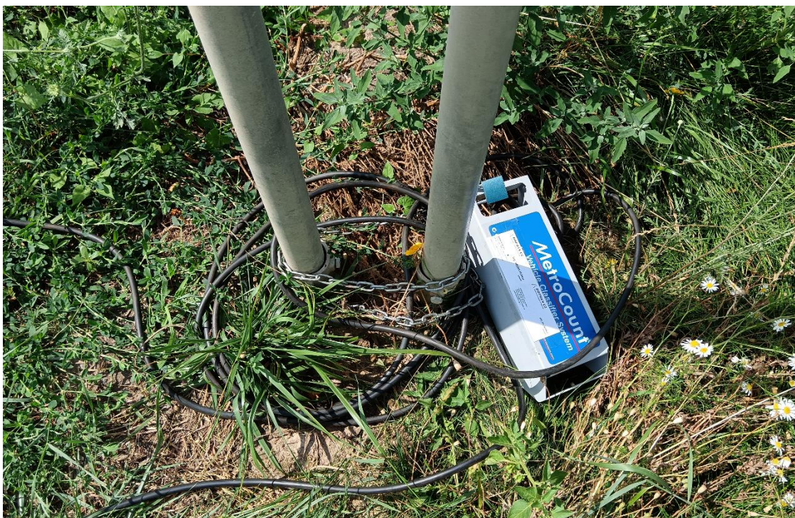
Obrázek 10: instalovaná měřící jednotka.
