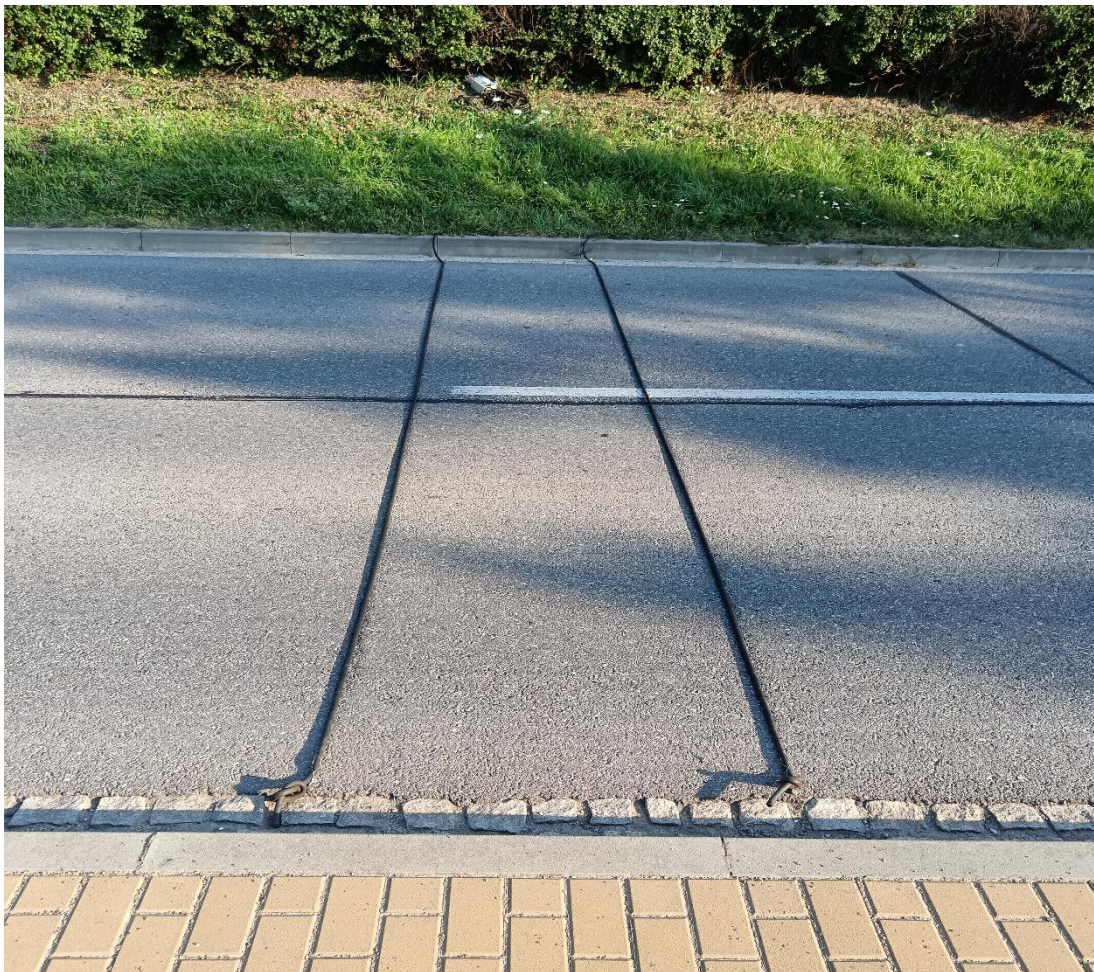
Obrázek 2 a 3: měřená komunikace s uloženým měřicím zařízením, instalované senzory v rozpětí 1 m
