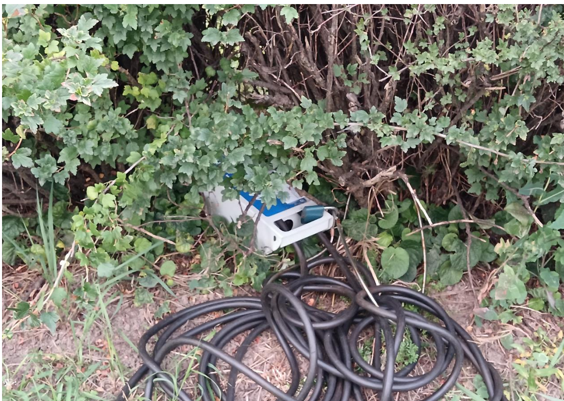
Obrázek 4: instalovaná měřicí jednotka.
